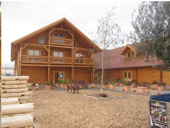
La seconde aile de la Ferme Maurer en construction. Le plus grand bâtiment Honka en rondin en France.
