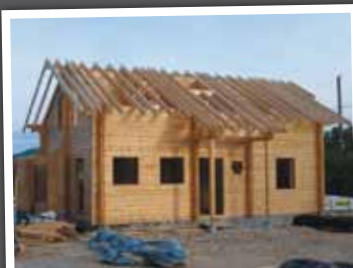
Jour 12 Pose de la charpente
