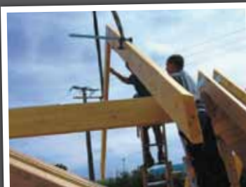
Jour 13 Les chevrons sont montés à la grue
