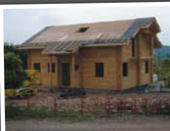
Jour 18 Pose du pare-pluie
