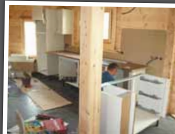
Jour 35 Installation de la cuisine
