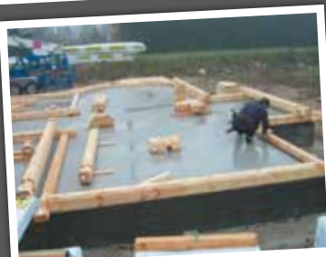
Jour 2 Démarrage du montage
